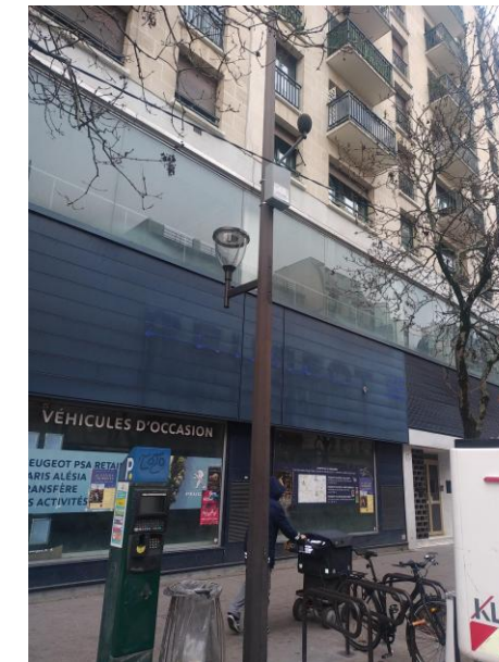
75014-PARIS-MOULIN état final
